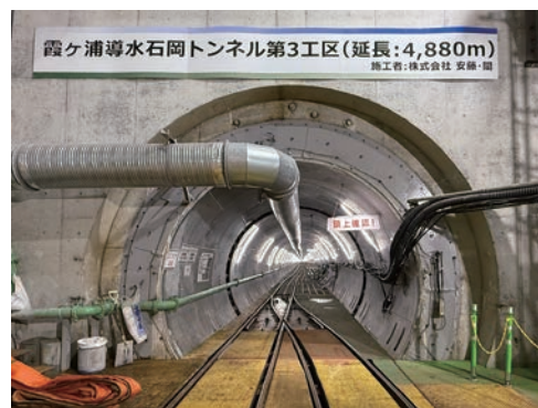
上飯沼立坑導水トンネル内部
